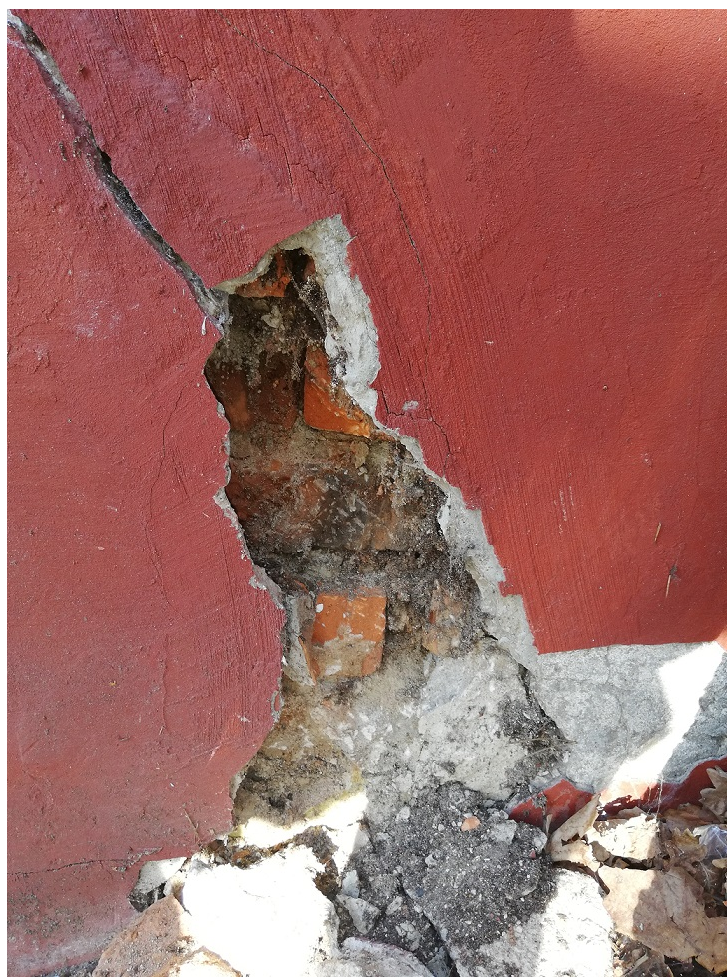
fot.2 odkrywka w miejscu pęknięcia
