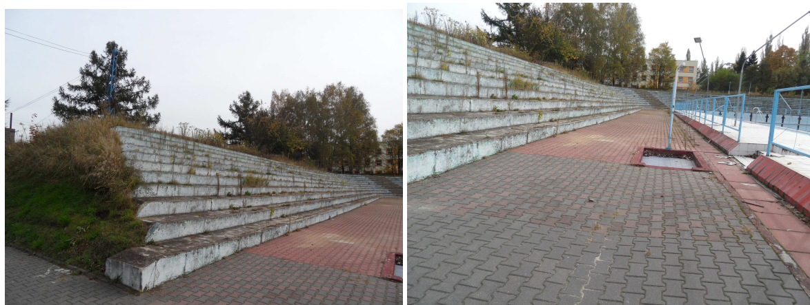
Fot. 1 Trybuna na skarpie ziemnej, plaża ka kostki betonowej (str. wschodnia)
