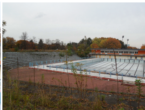
Fot. 5 Trybuna na skarpie ziemnej, plaża z kostki betonowej, elementy oświetleniowe i ogrodzenie do demontażu (str. zachodnia i południowo – wschodnia)
