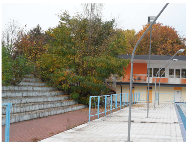
Fot. 5 Trybuna na skarpie ziemnej, plaża z kostki betonowej, elementy oświetleniowe i ogrodzenie do demontażu (str. zachodnia i południowo – wschodnia)
