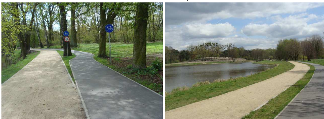
Zdjęcie lewe i prawe: ciąg spacerowy o nawierzchni wodoprzepuszczalnej oraz ścieżka rowerowa asfaltowa.
